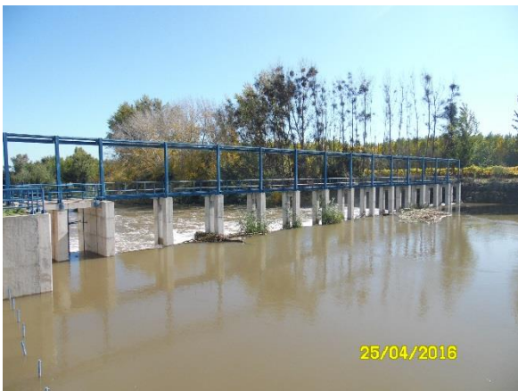
Bocatoma Uva Blanca (Captación Canal Nilahue Tramo I)
