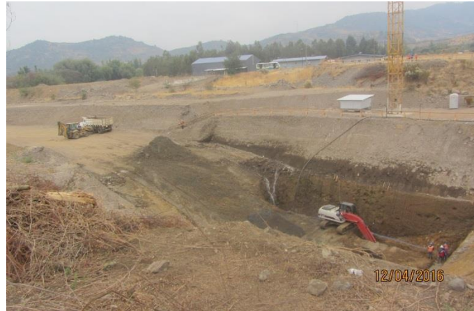
Excavación Calicatas para mejoramiento del Suelo de Fundación de la Casa de Máquinas. 4 metros profundidad.
