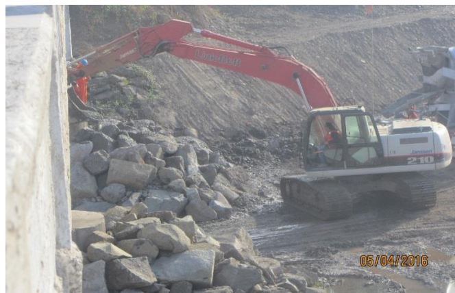
Hormigonado del Enrocado de las Cepas del Puente San Luis, con hormigón fluido.
