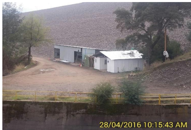
Taller de Misceláneos y Oficinas de Obra a los pies del Muro Principal.
