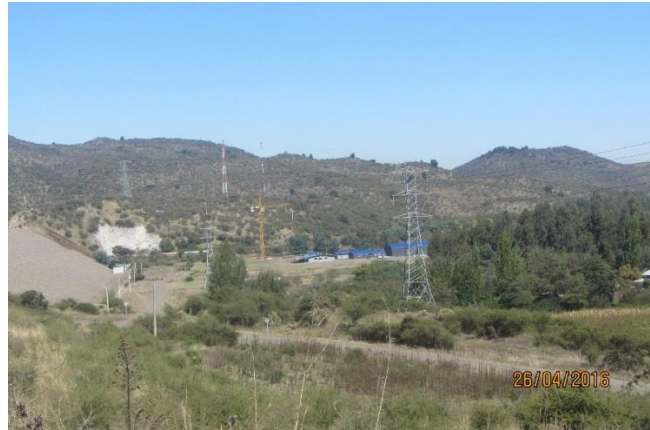
Vista panorámica desde el Muro lado Norte de la Instalación de Faenas. Se aprecia el Muro o Presa Principal. A los pies de éste, las Oficinas de Obra con su Taller de Misceláneos, la Torre de Comunicaciones, la Línea de 154 KV y la Instalación de Faenas.
